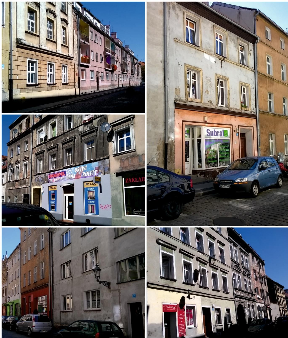
Fotografia 5. Przykłady wielorodzinnych budynków mieszkalnych będących w złym stanie technicznym
