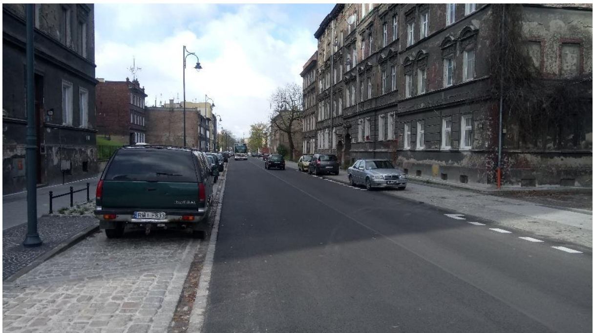
Zdjęcie 2. Ulica Ofiar Katynia - stan po inwestycji
