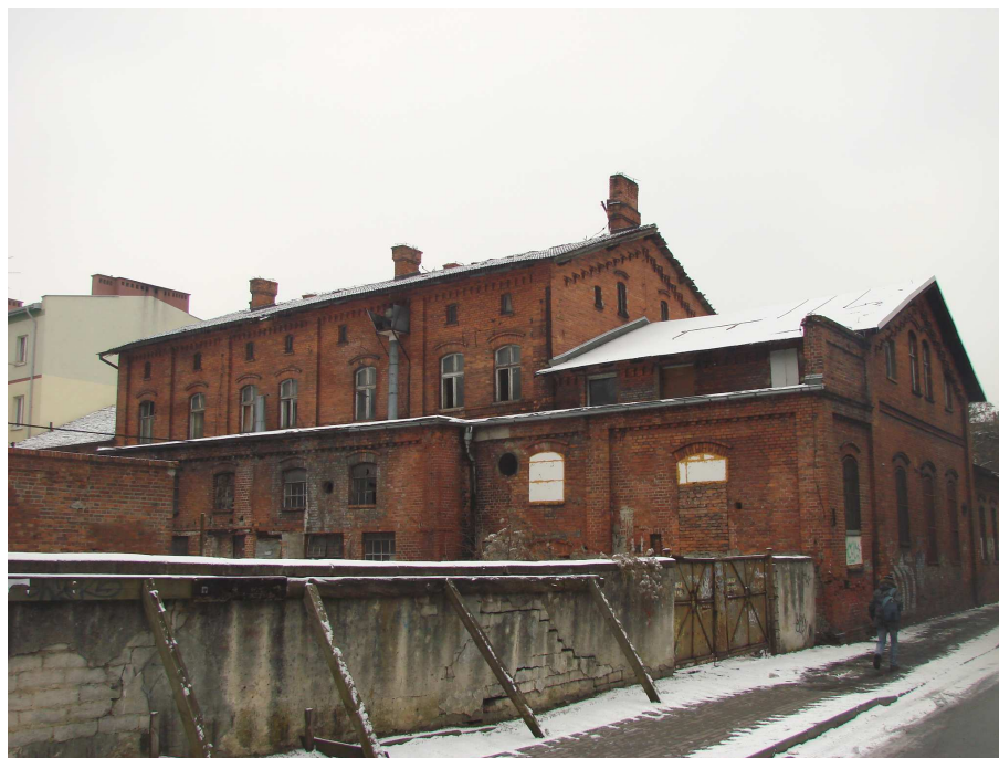
Fot. 3 – Widok budynku głównego od strony północno-zachodniej
