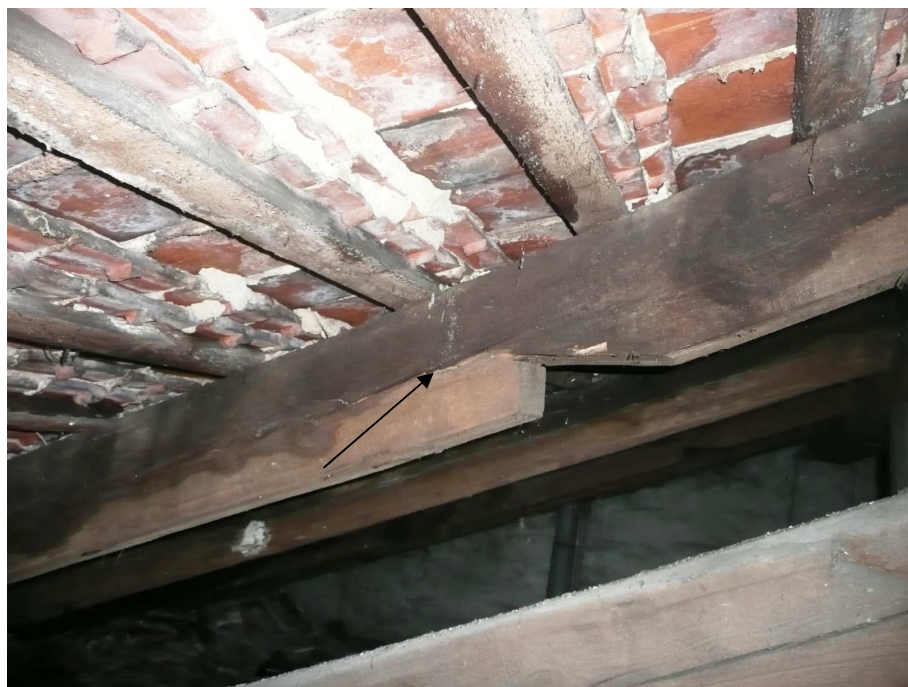
Fot. 11 – Bryła wschodnia. Widoczny zaciós wtórnie wbudowanej krokwi łączący się ze spękaniem podłużnym.
