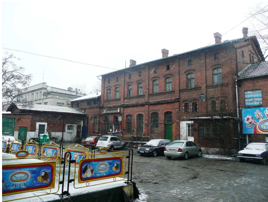
Fot. 1 – Widok od strony południowo-wschodniej budynku przybudówki /z lewej strony/ oraz bryły zachodniej i centralnej budynku głównego.
