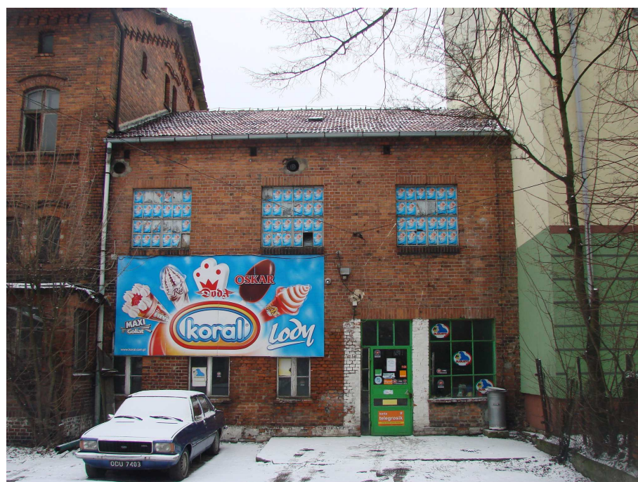
Fot. 2 – Widok od strony południowej bryły zachodniej budynku głównego
