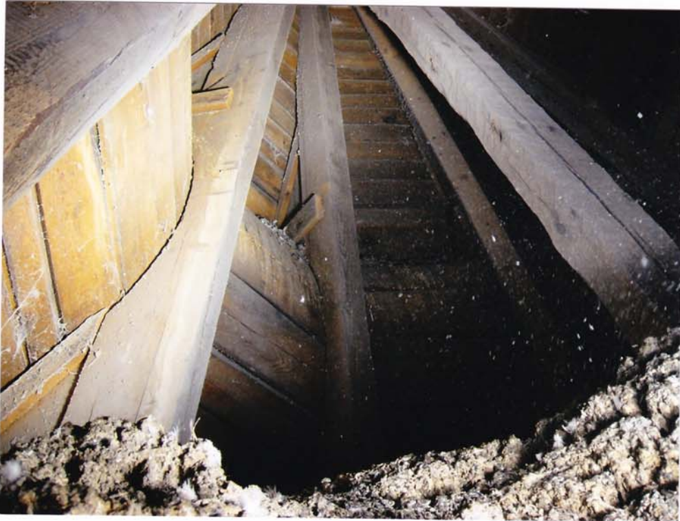
fot.93. Hełm południowy – górna partia helmu. Widoczna drewniana 8-boczna kopuła. Deskowanie pod pokryciem i elementy drewniane konstrukcji bez widocznych uszkodzeń.
