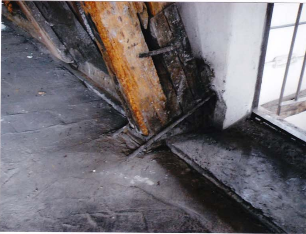
fot.45. Skrzydło zachodnie – I kondygnacja. W skrzydle zachodnim w partiach południowej i północnej są stalowe pręty, spinające dołem konstrukcje rozporową więźby dachowej ze stropem masywnym nad I piętem. Identyfikacyjnie spięte ze stropami są wszystkie elementy rozporowe więźb dachowych w skrzydłach południowym i północnym. W głębi krokiew dołem owinięta papą i zabetonowana.
