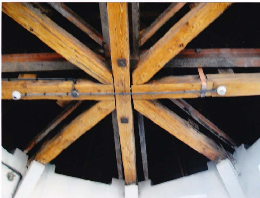
fot.110. Helm północny – dolna partia helmu. Widoczny strop drewniany poniżej tej partii helmu w gwiazdastym układzie belek, a nad nim konstrukcja stalowego wzmocnienia helmu.
