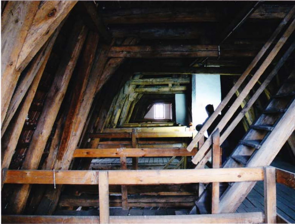
fot.29. Skrzydło zachodnie – II kondygnacja, widok ogólny. Widoczna konstrukcja rozporowa więźby dachowej.
