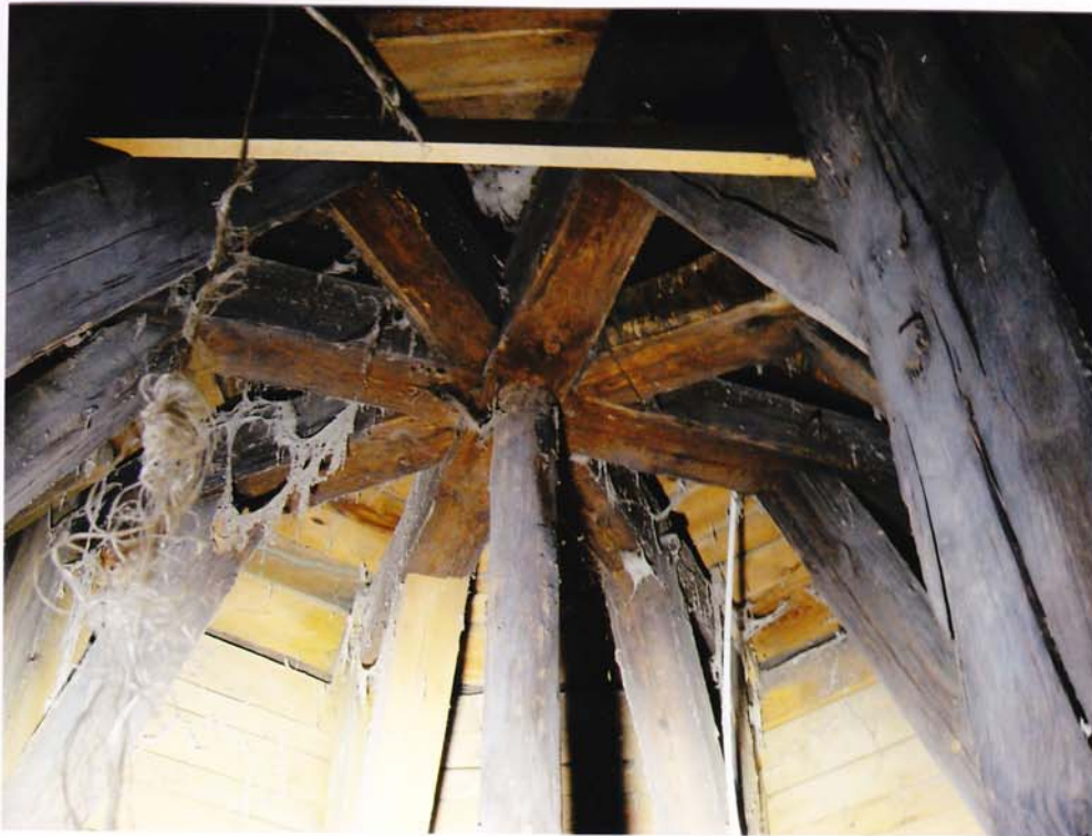
fot.96. Helm południowy – dolna partia helmu. Widoczny strop nad tą partią, o gwiazdzistym układzie belek, podparty dodatkowo słupem centralnym.
