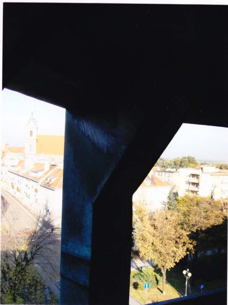
fot.104. Helm północny – latarnia. Widoczne zbliżenie drewnianego słupa obwodowego, pokrytego szczelnie blachą miedzianą.
