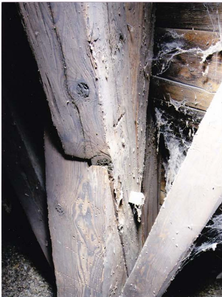
fot.68. Środkowa partia helmu – widoczne połączenia elementów helmu. W połączeniu szczeliny między elementami.
