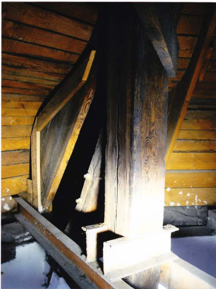
fot.109. Helm północny – dolna partia helmu. Drewniany element konstrukcji helmu oparty na stalowej konstrukcji wzmocnienia.
