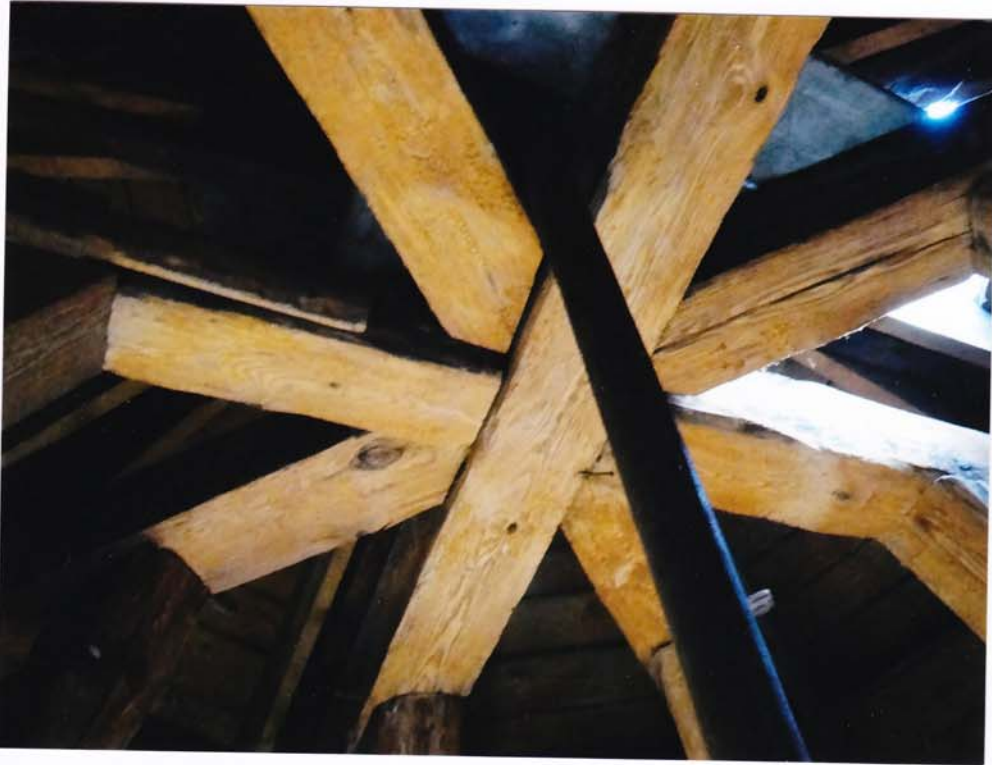
fot.105. Helm północny – dolna partia helmu. Widoczny strop nad tą partią, o gwiaździstym układzie belek.
