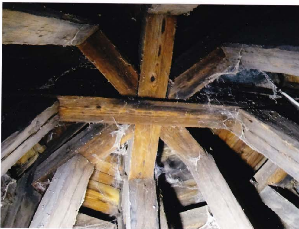
fot.67. Środkowa partia helmu – widoczny strop nad tą partią o gwiazdzistym układzie belek. Część zastrzałów jest splekanych podłużnie.
