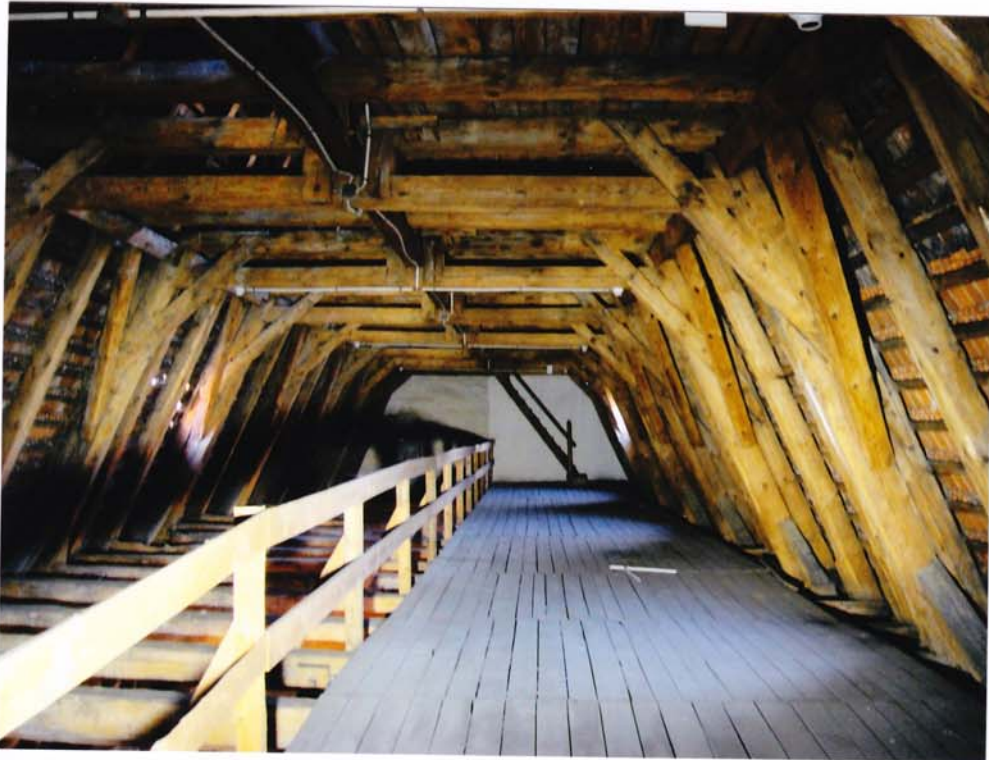
fot.11. Skrzydło południowe – II kondygnacja, widok ogólny. Widoczna konstrukcja rozporowa więźby dachowej.
