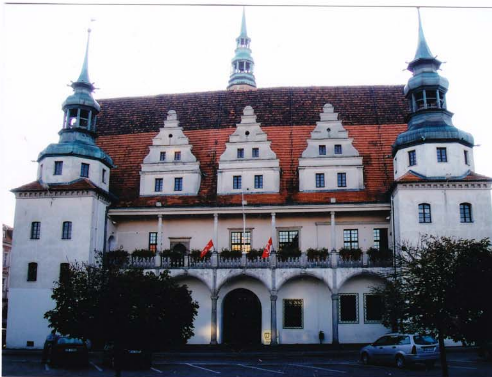
fot.1. Ratusz w Brzegu – elewacja frontowa zachodnia. Dach pokryty dachówką ceramiczną karpiówka w koronkę, w górnej partii stara dachówka grubości 20 mm, w dolnej partii dachówka współczesna. Po lewej stronie hełm północny, po prawej hełm południowy, w głębi wieża ratusza z hełmem.
