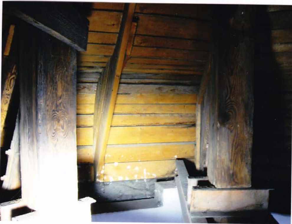
fot.106. Helm północny – dolna partia helmu. Widoczne wnętrze helmu – na deskowaniu pokrycia nie ma śladów zacieków i zniszczeń, elementy drewniane konstrukcyjne bez zniszczeń.
