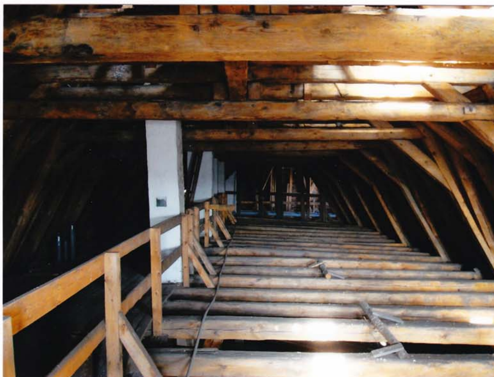
fot.52. Skrzydło północne – II kondygnacja, widok ogólny. Widoczna konstrukcja rozporowa więźby dachowej.
