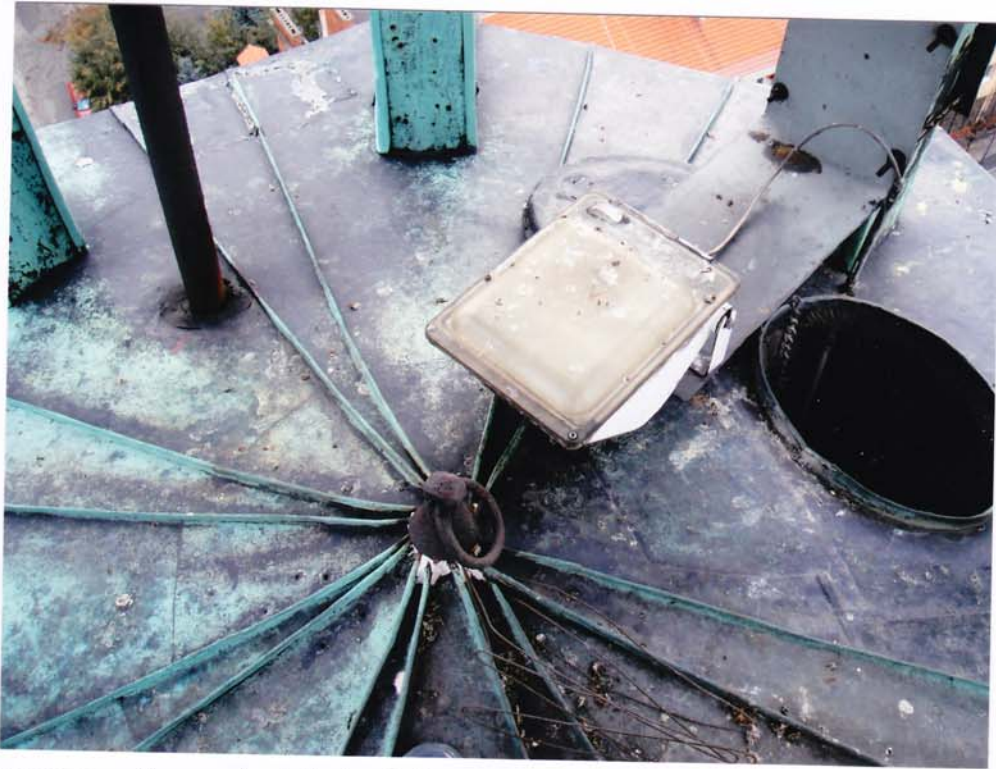
fot.65. Górna latarnia – widoczne pokrycie blachą miedzianą stropu nad środkową partią helmu, w głębi obwodowe słupy drewniane pokryte blachą.
