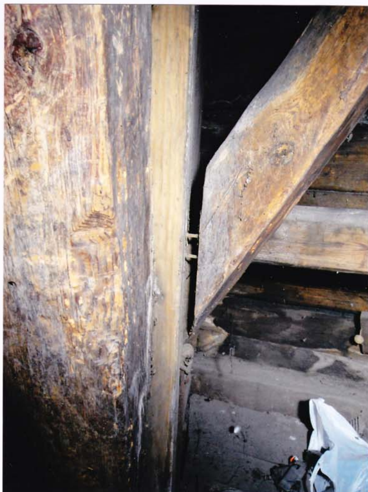
fot.78. Dolna partia helmu – widoczna szeroka szczelina między słupem i zastrzałem. Zastrzał prócz czopu jest mocowany ze słupem dwoma gwoździami o przekroju kwadratowym.
