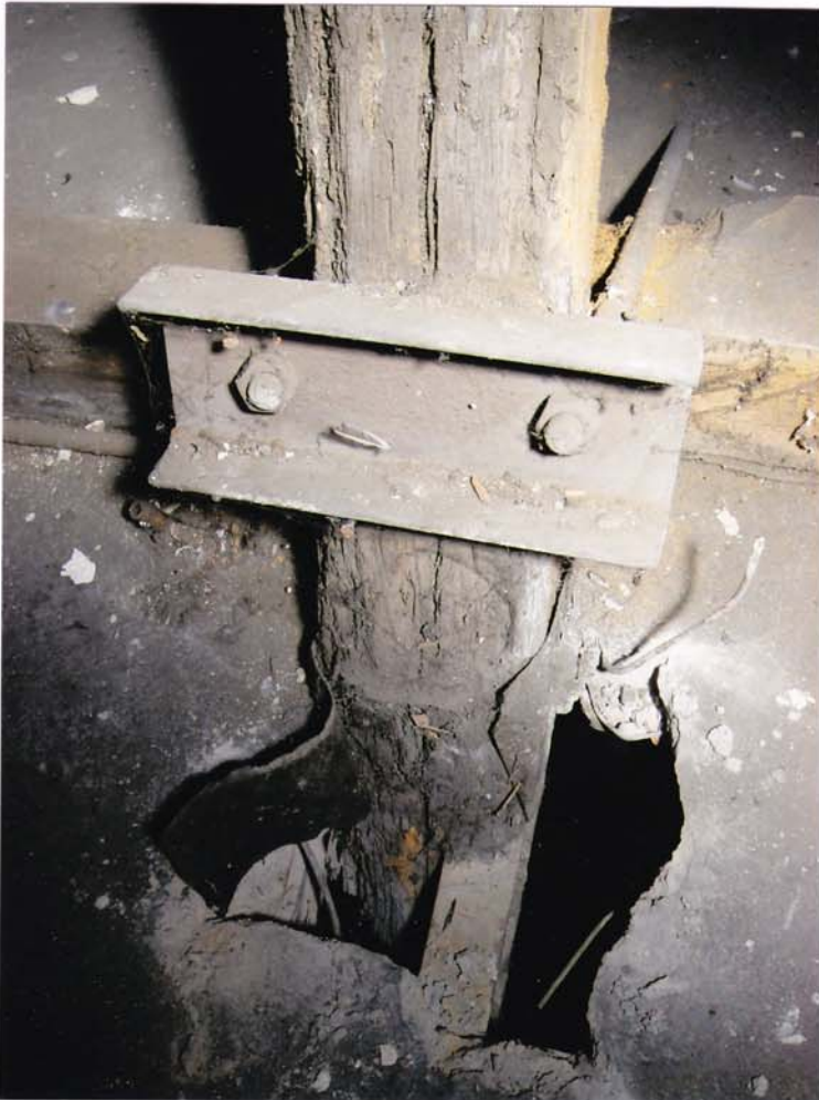
fot.45. Skrzydło zachodnie – I kondygnacja. W skrzydle zachodnim w partiach południowej i północnej są stalowe pręty, spinające dołem konstrukcje rozporową więźby dachowej ze stropem masywnym nad I piętem. Identyfikacyjnie spięte ze stropami są wszystkie elementy rozporowe więźb dachowych w skrzydłach południowym i północnym. W głębi krokiew dołem owinięta papą i zabetonowana.
