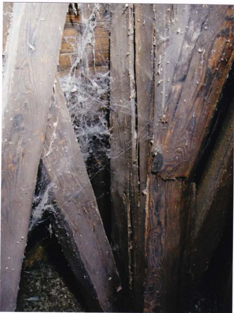
fot.69. Środkowa partia helmu – widoczny słup o licznych spękaniach podłużnych, o znacznej rozwarłości.
