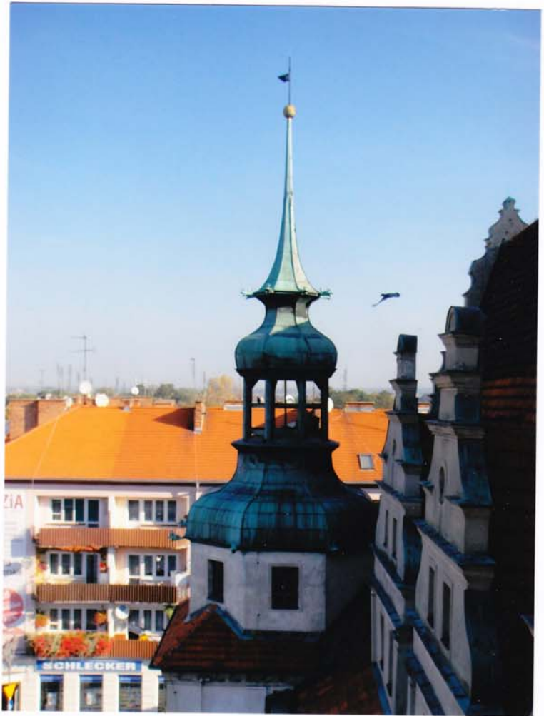
fot.101. Helm północny – o konstrukcji drewnianej, kryty błachą miedzianą na deskowaniu. Na starym pokryciu widoczne ciemne ślady zacieków.
