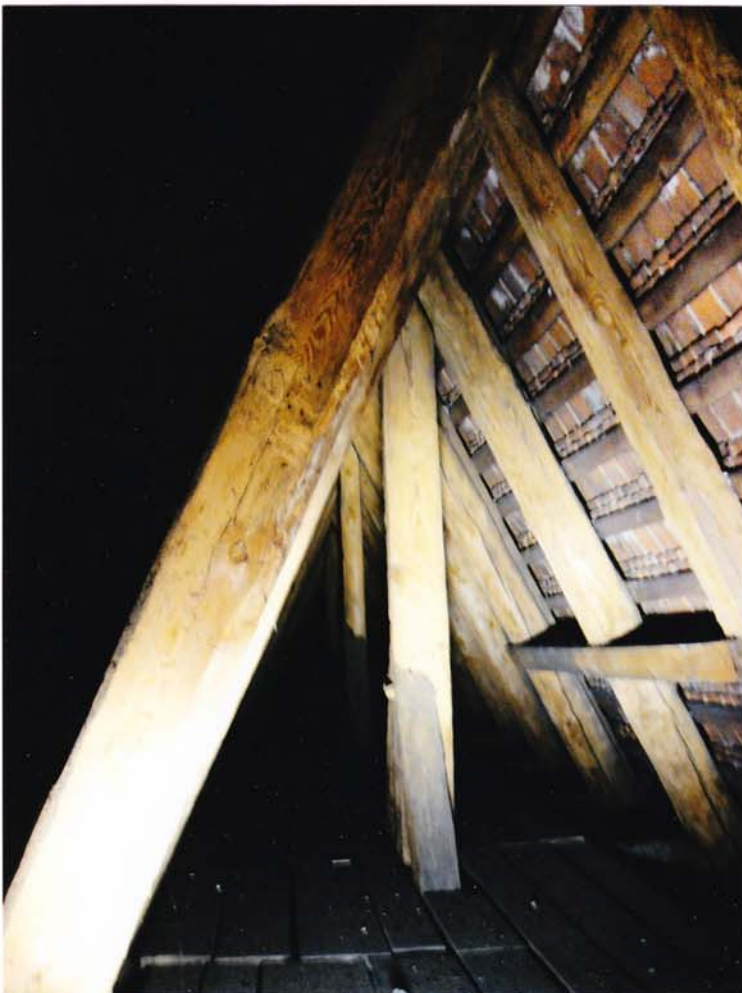
fot.8. Skrzydło południowe – IV kondygnacja. Widoczne krokwie splekane podłużnie.
