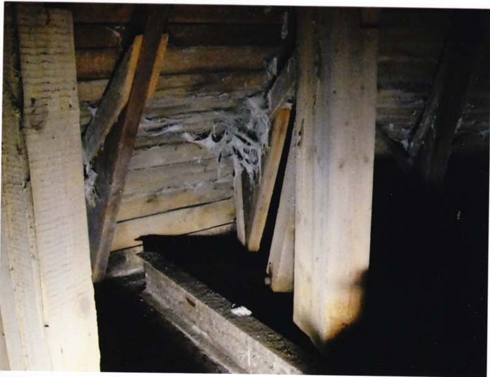
fot.97. Helm południowy – dolna partia helmu. Widoczne wnętrze helmu – na deskowaniu pokrycia nie ma śladów zacieków i zniszczeń, elementy drewniane konstrukcyjne bez zniszczeń. Dołem widoczna belka stalowa konstrukcji wzmacniającej oparcie helmu.
