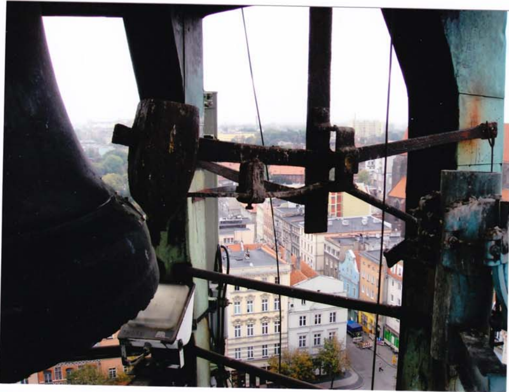
fot.71. Dolna latarnia – widoczne obwodowe słupy drewniane szczelnie pokryte blachą miedzianą,
