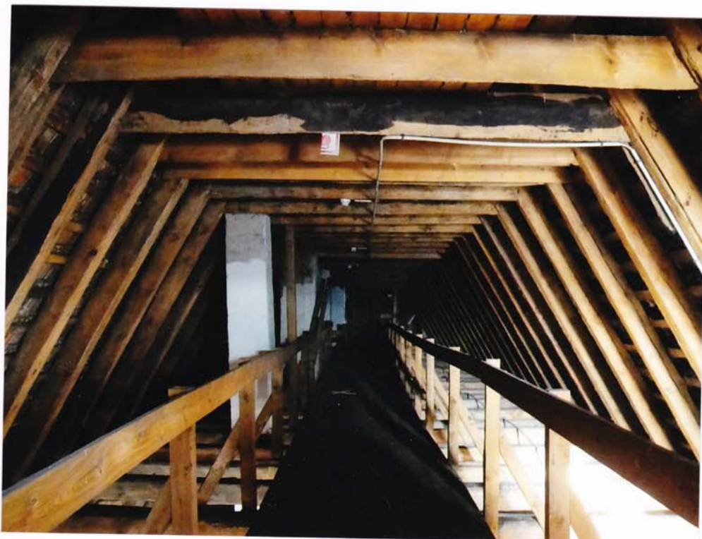
fot.49. Skrzydło północne – III kondygnacja, widok ogólny.
