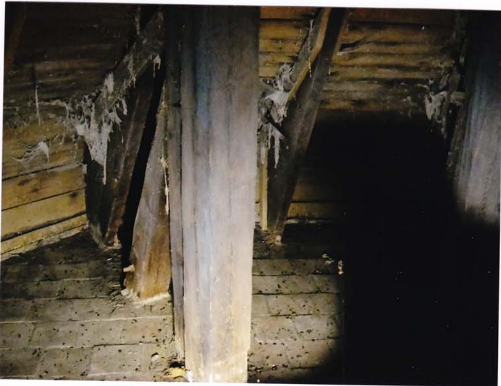
fot.98. Helm południowy – dolna partia helmu. Widoczne wnętrze helmu – na deskowaniu pokrycia nie ma śladów zacieków i zniszczeń, elementy drewniane konstrukcyjne bez zniszczeń. Dołem posadzka z płytek ceramicznych.
