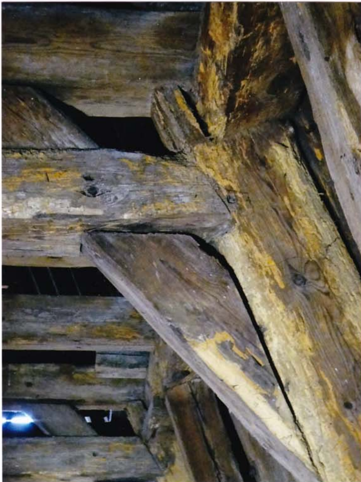
fot.32. Skrzydło zachodnie – II kondygnacja. Elementy konstrukcji rozporowej i płatew są zniszczone powierzchniowo przez owada Spuszczela.
