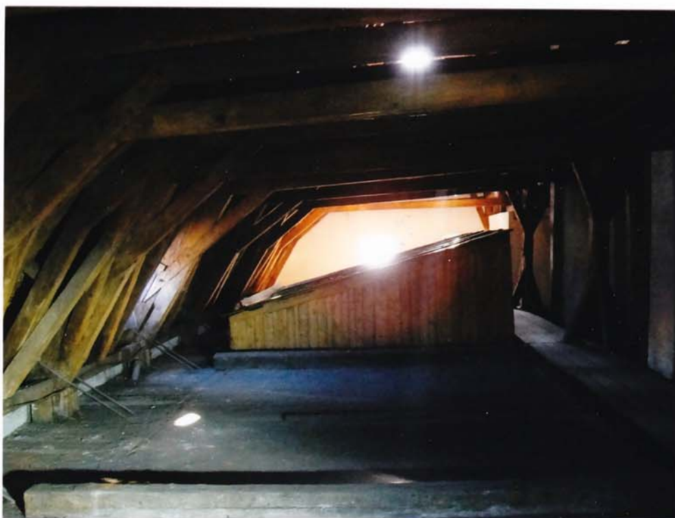
fot.55. Skrzydło północne – I kondygnacja, widok ogólny. Widoczna konstrukcja rozporowa więźby dachowej.
