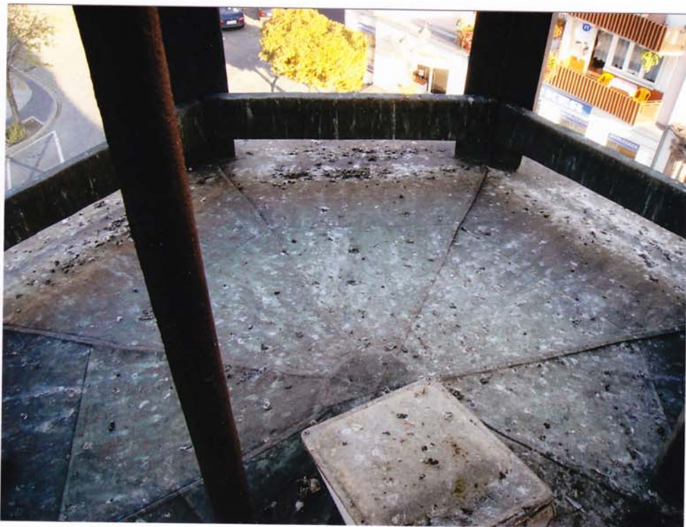
fot.103. Helm północny – latarnia. Widoczne pokrycie blachą miedzianą stropu nad dolną partią helmu. W głębi drewniane słupy obwodowe pokryte szczelnie blachą miedzianą.
