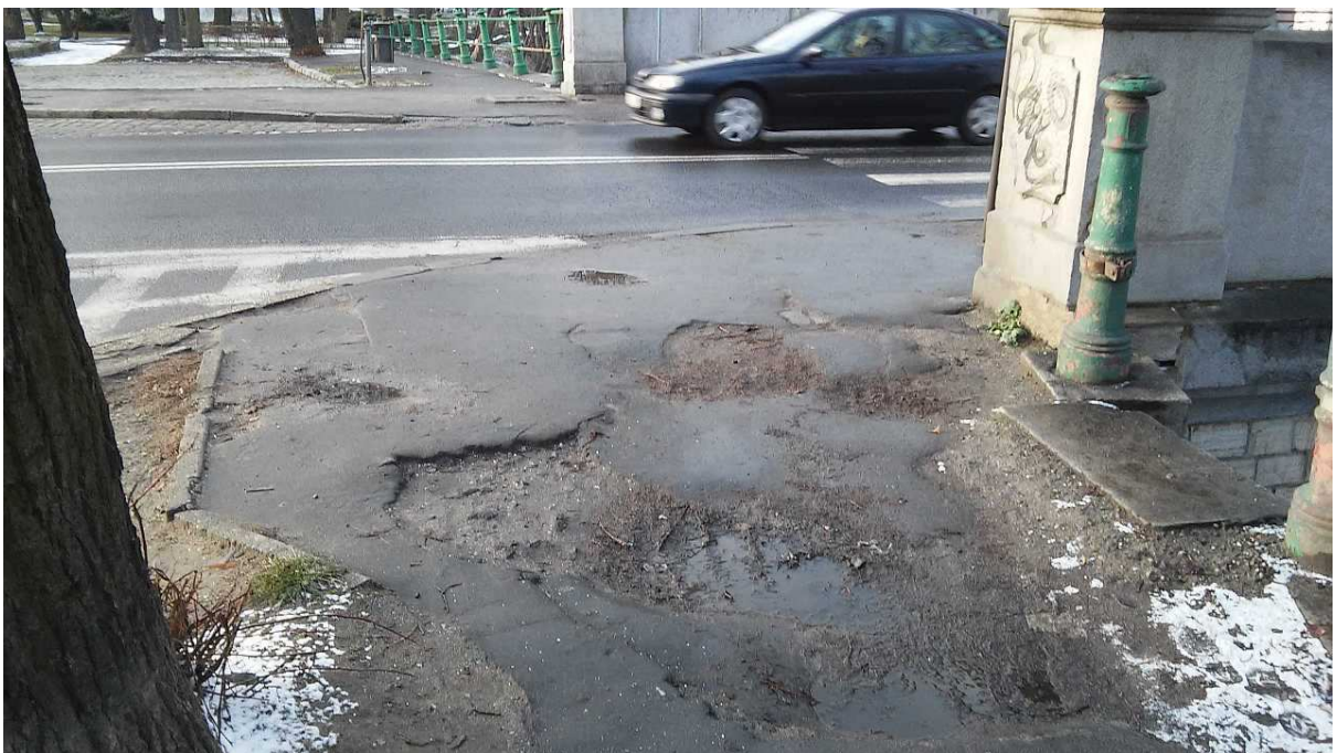
Rys. 1.3 Widok rejonu przejścia dla pieszych przed mostem
