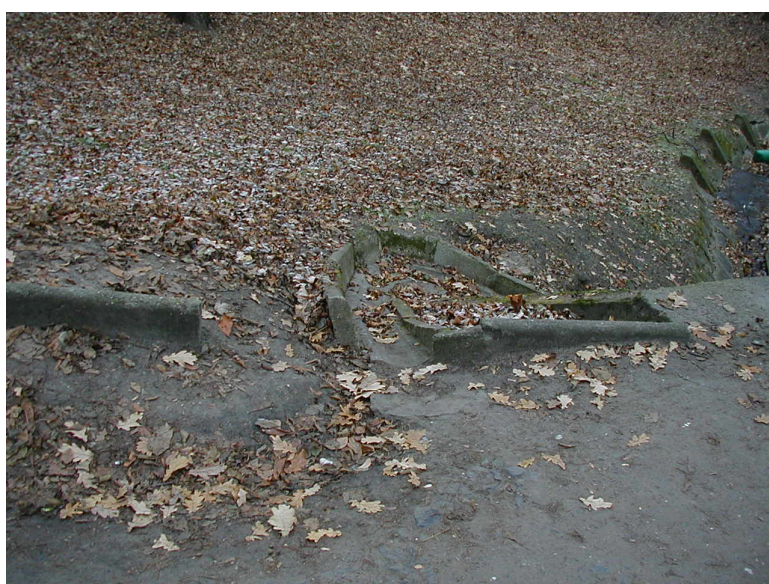
Wlot do ścieku skarpowego
