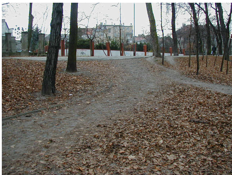
Stan nawierzchni alejki w jej zachodniej części
