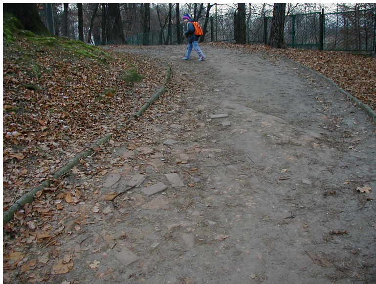
Stan nawierzchni alejki w jej zachodniej części – gruz ceglany
