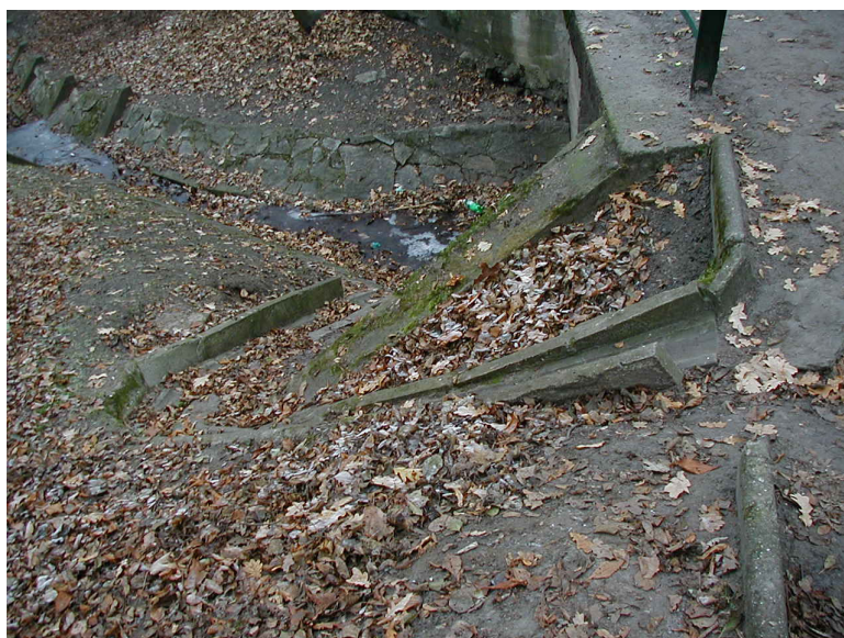
Stan ścieku skarpowego
