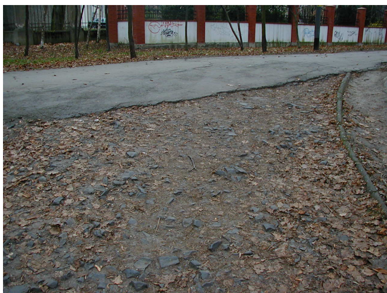
Stan nawierzchni alejki w jej zachodniej części – włączenie do alejki o naw. asfaltowej
