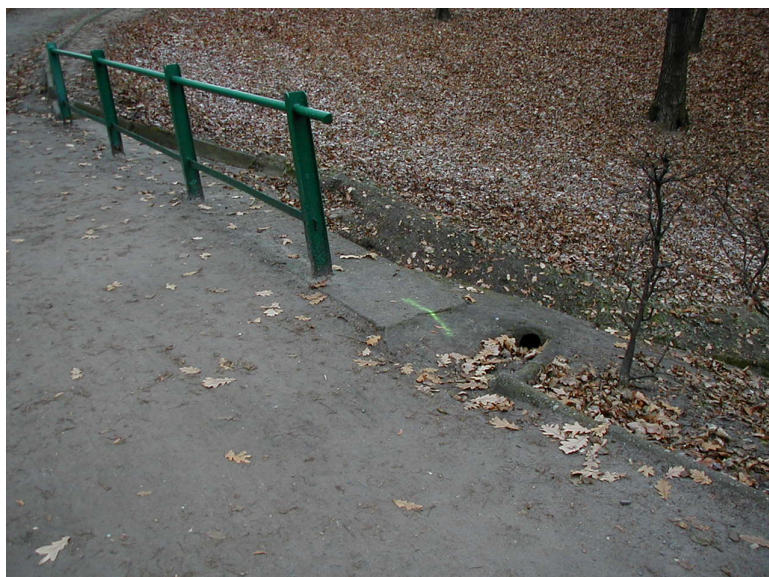
Wlot do rury odprowadzającej wody ze wschodniej części alejki
