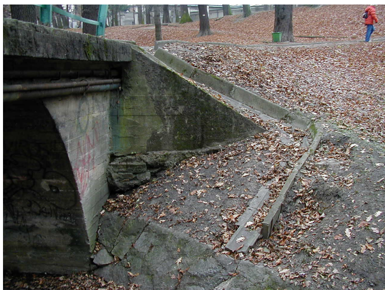
Stan ścieku skarpowego
