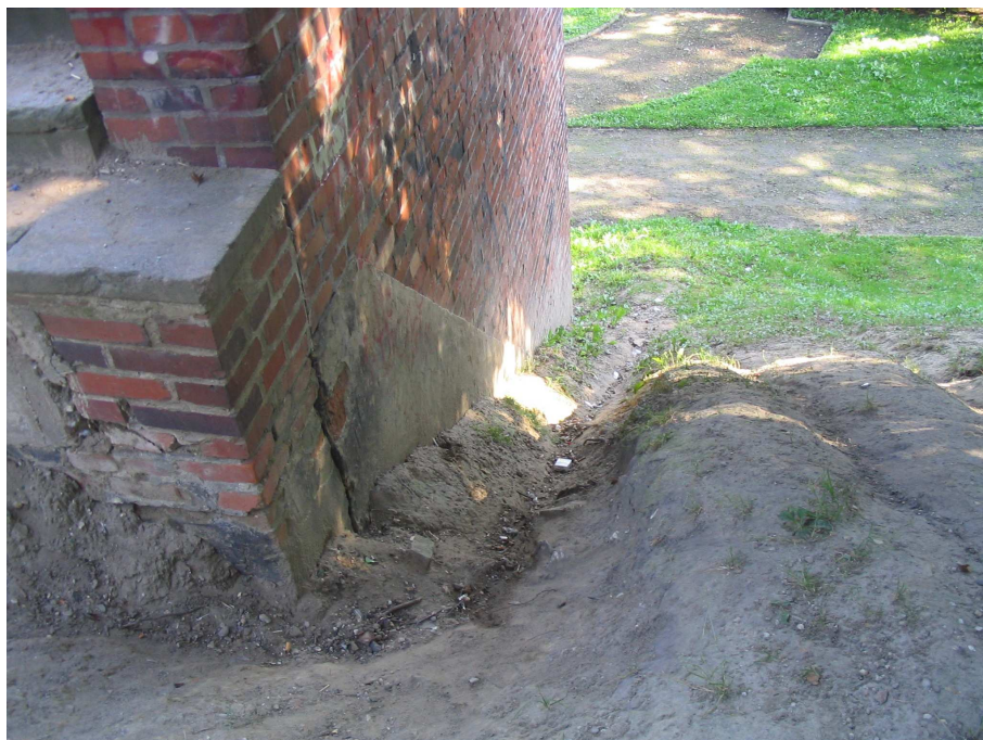
Fot. 5 Widok skarpy przy ścianie południowo-wschodniej. Widoczne koryto erozyjne , fragment cokołu cemen- towego.
