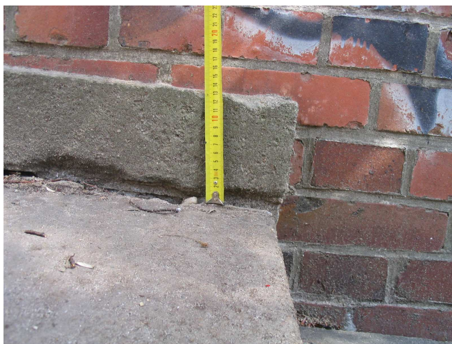
Fot. 10 Fragment tarasu. Widoczne szczeliny na styku cokół – stopnica. Widoczne zabrudzenie grafitti.
