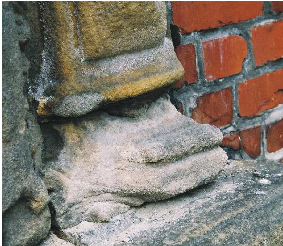
22. Stan aktualny, fragment dolnej części pilastra zach. - widoczne zasolenie i dezintegracja piaskowca
