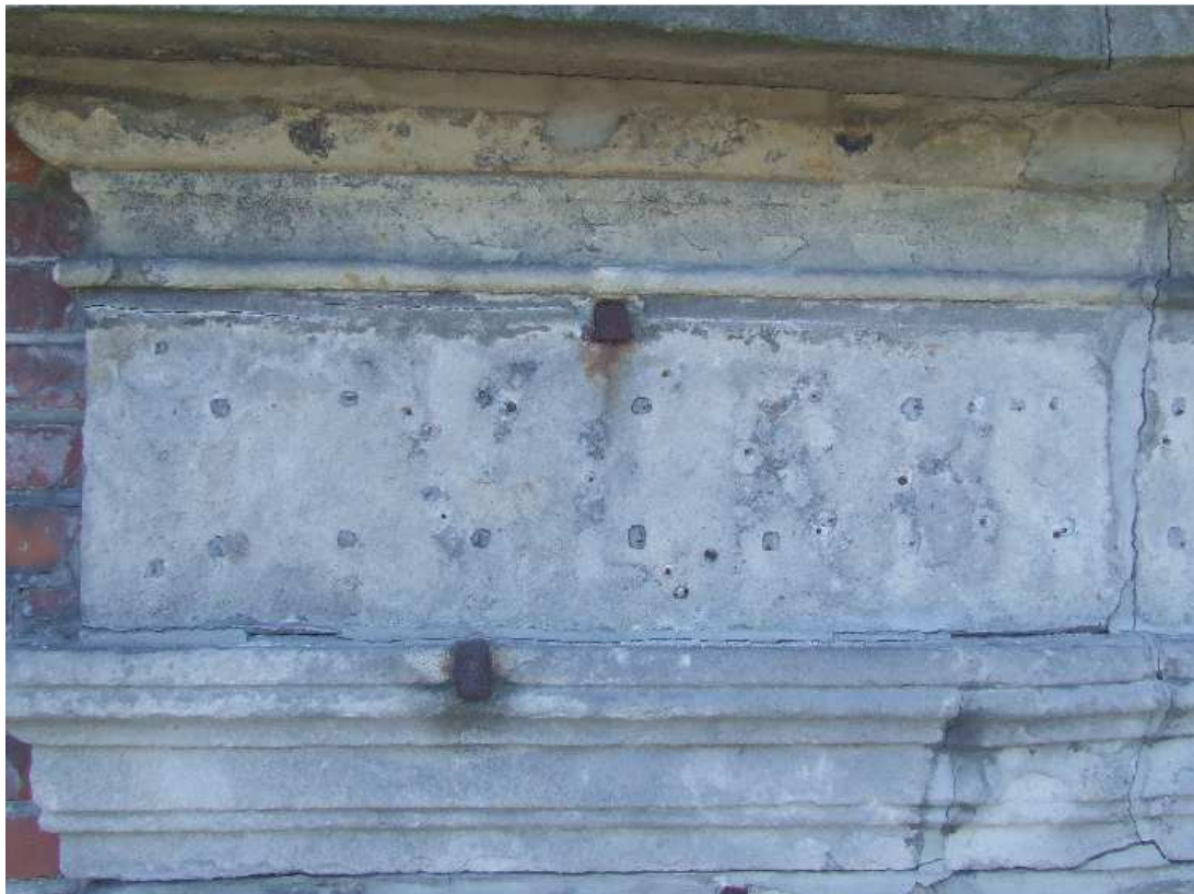
25. Stan aktualny - początkowy fragment fryzu - widoczne zarysy liter R i B oraz gniazda montażowe.
