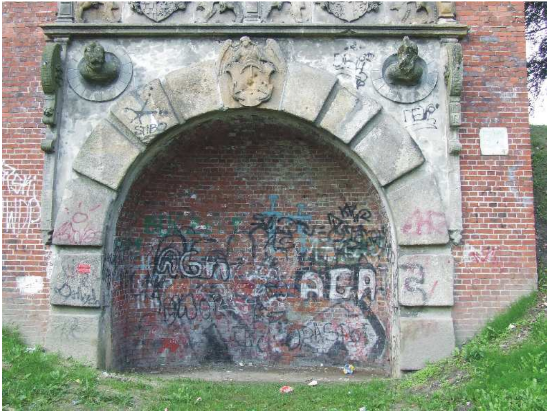
12. Stan aktualny, nisza otworu bramnego
