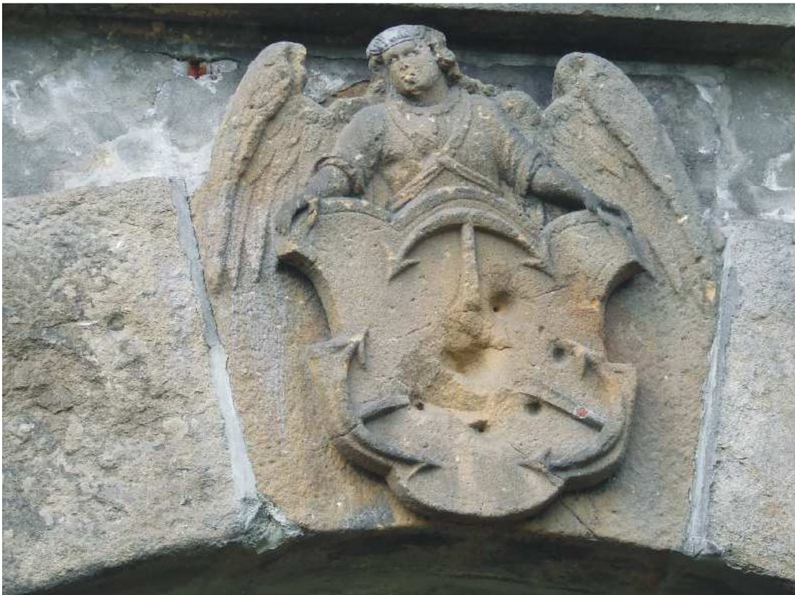
13. Stan aktualny, zwornik otworu bramnego
