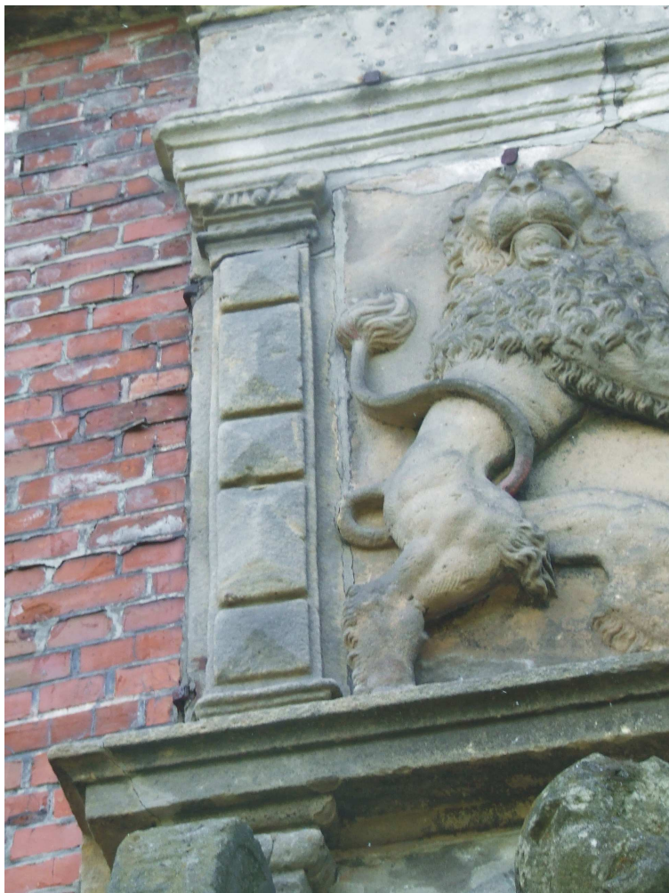
22. Stan aktualny, fragment dolnej części pilastra zach. - widoczne zasolenie i dezintegracja piaskowca
