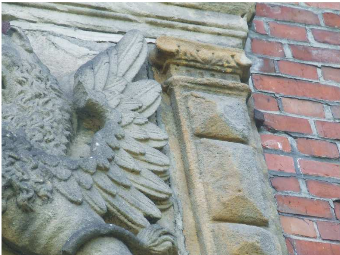
20. 21. Stan aktualny, fragmenty środkowego i zach. pilastra. Widoczna dezintegracja piaskowca oraz zatarcie konturów reliefu
