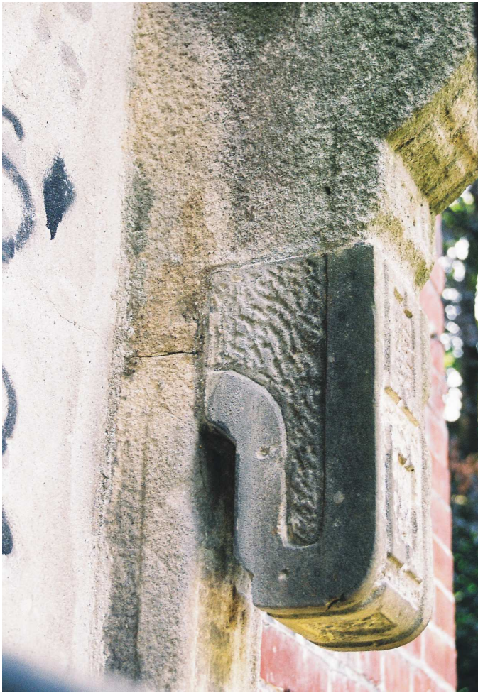
25. Stan aktualny - początkowy fragment fryzu - widoczne zarysy liter R i B oraz gniazda montażowe.
