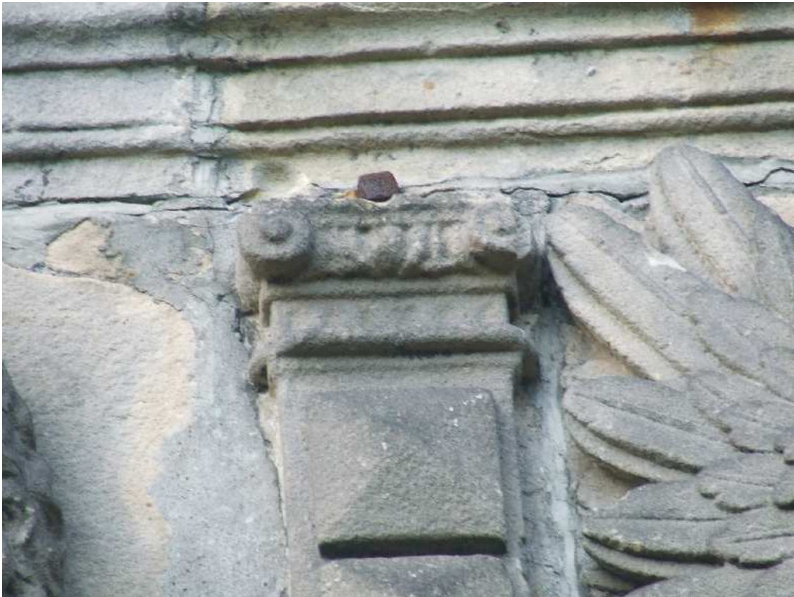
20. 21. Stan aktualny, fragmenty środkowego i zach. pilastra. Widoczna dezintegracja piaskowca oraz zatarcie konturów reliefu
