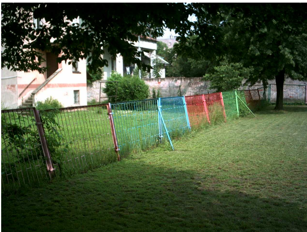
Widok stanu istniejącego – odcinek H
