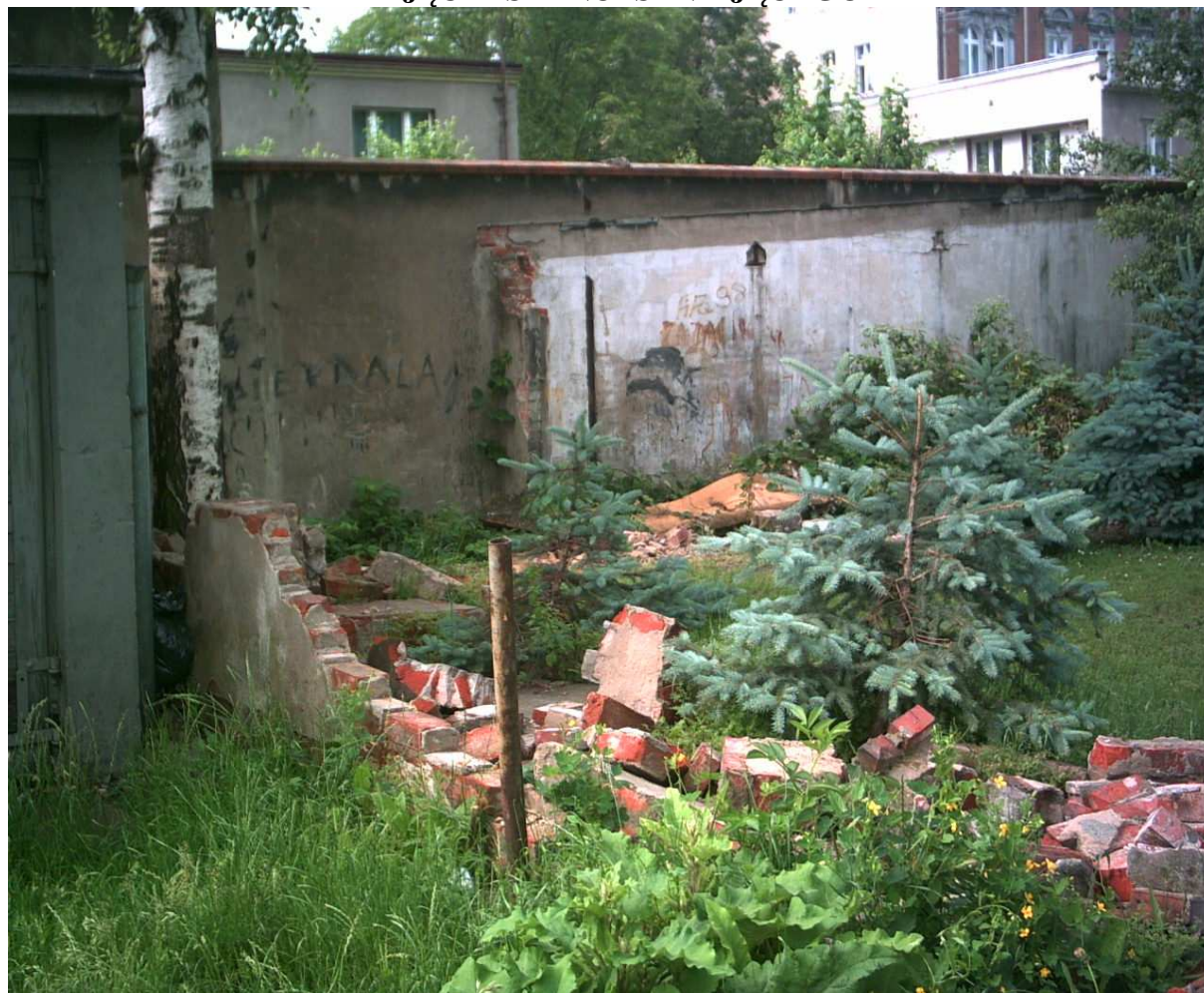
Widok stanu istniejącego – odcinek E,D i C
