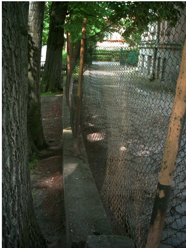
Stan istniejący- odcinek I
