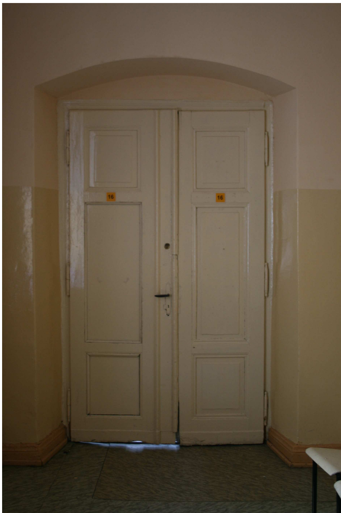
I piętro- istniejąca stolarka wewnętrzna
