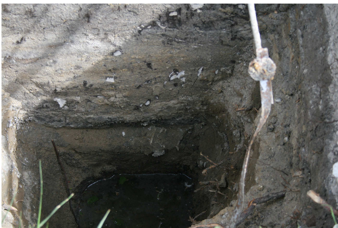
Woda na poziomie posadowienia
