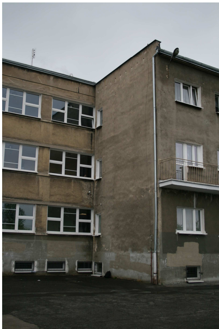
Widok na narożnik wewnętrzny między segmentem Ci D- miejsce lokalizacji szybu.
