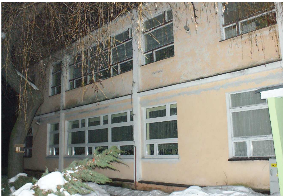
Ogólny widok elewacji szkoły (I p. –sala Multieksploratorium)
